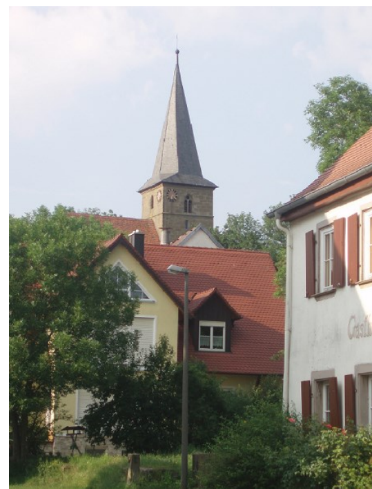
Vor der Renovierung
